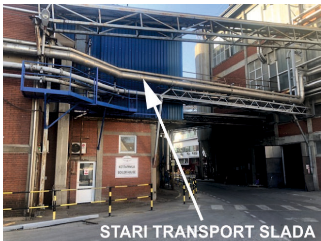
Sl. 1.4 Sistemi za transport slada (stari i novi) kao izvori specifične buke „Apatinske pivare Apatin“ doo Apatin i objekat Varione
