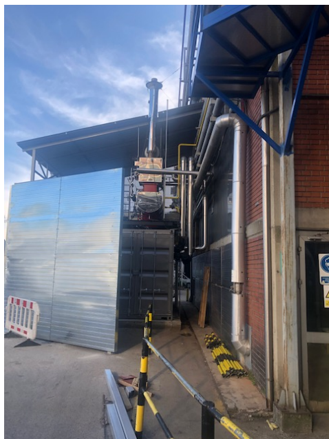
Sl. 1.2 Kogenerator sa zvučnom barijerom kao izvor specifične buke „Apatinske pivare Apatin“ doo Apatin
