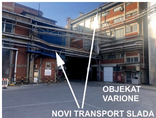
Sl. 1.4 Sistemi za transport slada (stari i novi) kao izvori specifične buke „Apatinske pivare Apatin“ doo Apatin i objekat Varione
