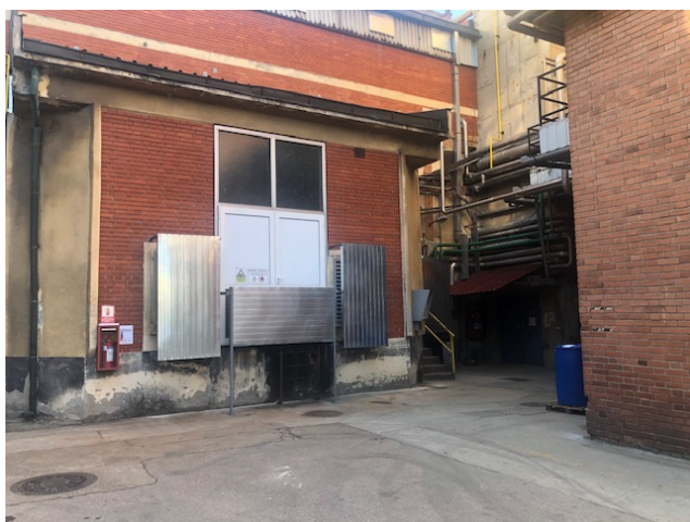
Sl. 1.2 Kogenerator sa zvučnom barijerom kao izvor specifične buke „Apatinske pivare Apatin“ doo Apatin
